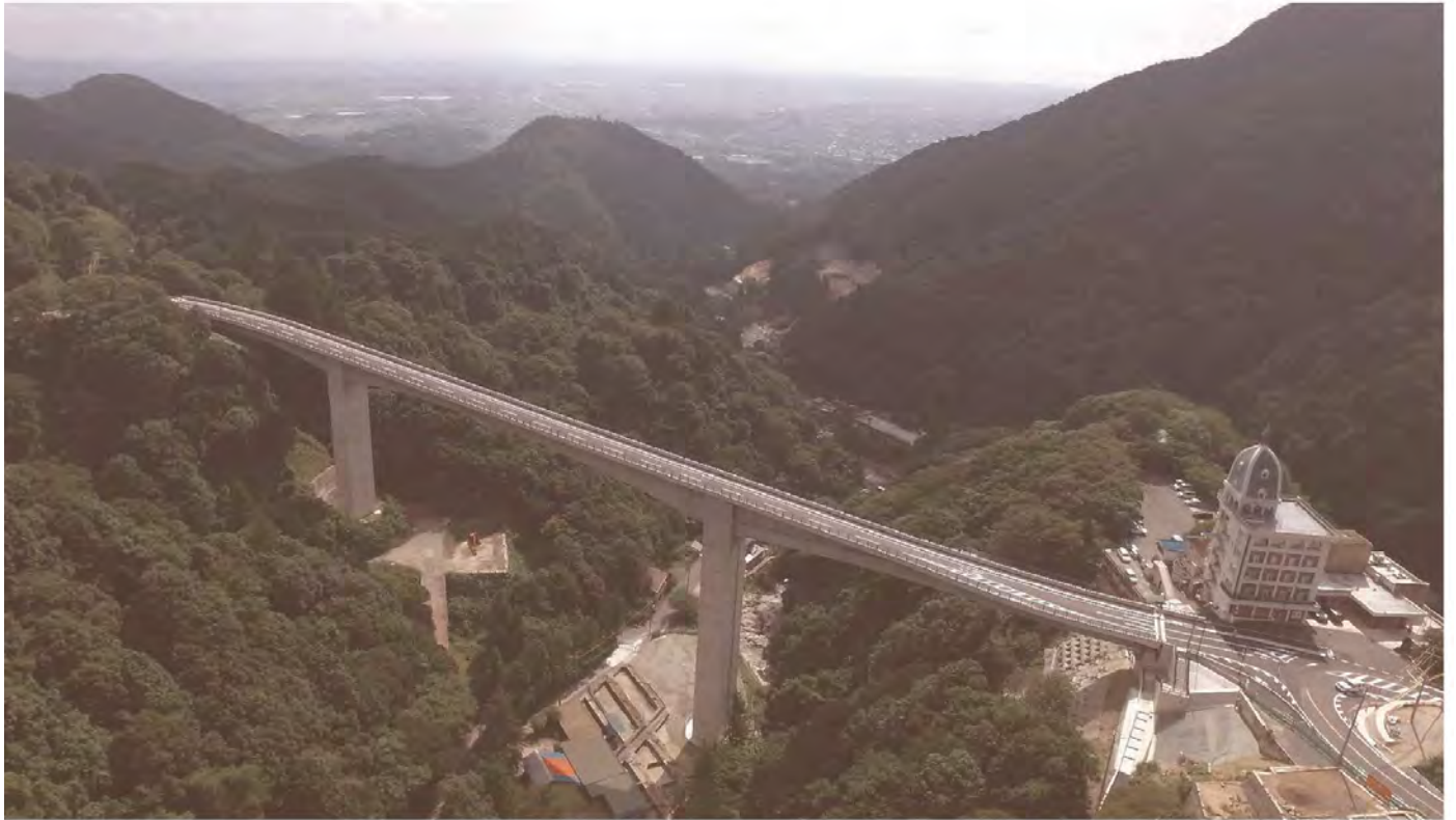
平成 30 年 8 月 24 日 湯の山かもしか大橋 開通
